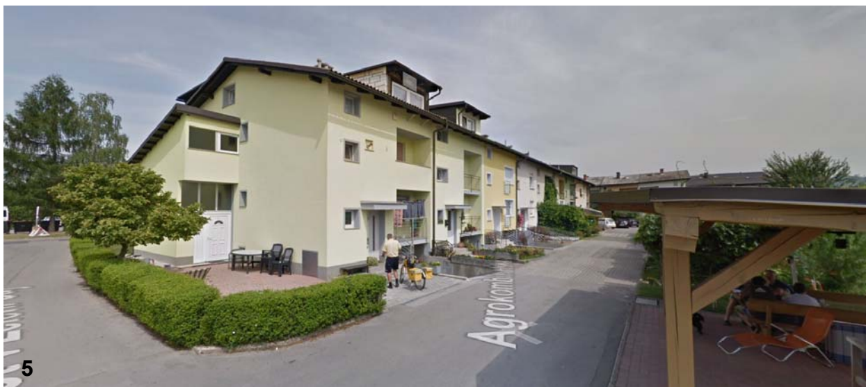
Slika 12: Pogled na niz vrstnih hiš ob Agrokombinatski cesti; Vir: https://www.google.com/maps
