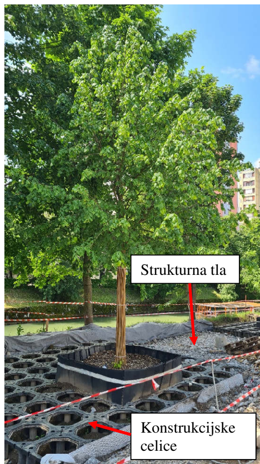
Slika 11: Sadilna jama je obdana s konstruktivskimi celicami, ki so med seboj povezane s strukturnimi tlemi.
