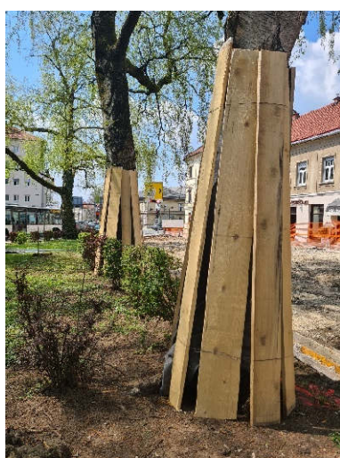
Slika 9: Zaščita debel na gradbiščih, ko zaščita rastnega prostora iz objektivnih razlogov ni mogoča.
