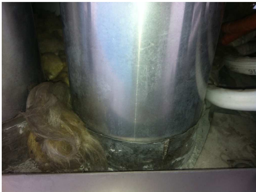
Slika 22: streha, objekt F3, Zelena Jama – dimnik na osi 5, zračniki so izolirani, suha izolacija
