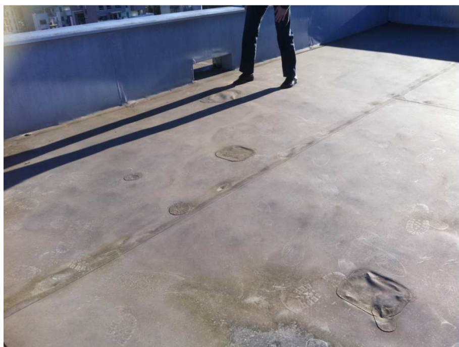
Slika 17: streha - objekt F3, Zelena Jama, sanacija obstoječe folije izvedena v preteklosti
