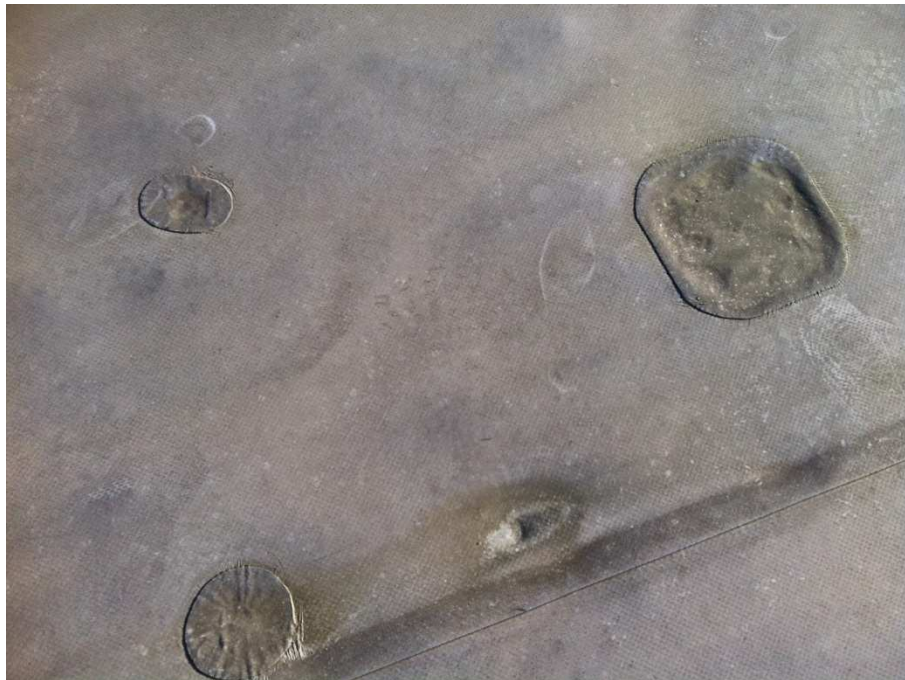
Slika 18: streha - objekt F3, Zelena Jama, sanacija obstoječe folije izvedena v preteklosti
