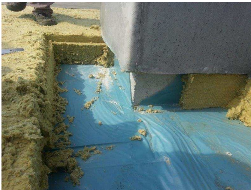
Slika 12: streha objekt F3, Zelena Jama, obstoječa toplotna izolacija, debelina 12cm
