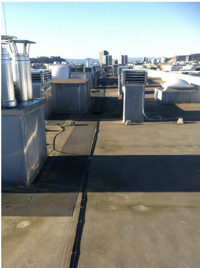
Slika 16: streha - objekt F3, Zelena Jama, vidna hojnica na sredini in odtočniki
