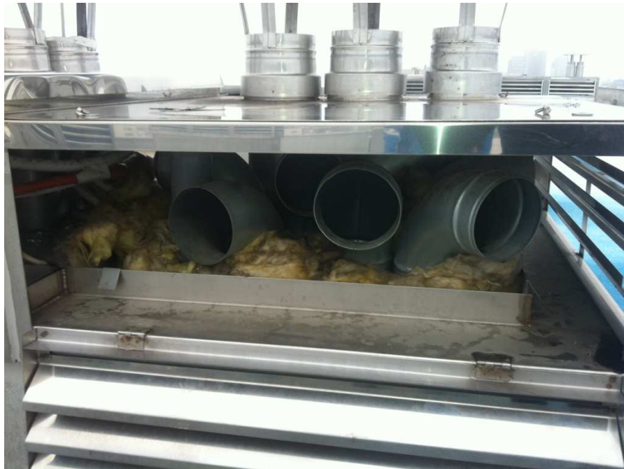
Slika 21: streha, objekt F3, Zelena Jama – dimnik na osi 5, zračniki so izolirani, suha izolacija
