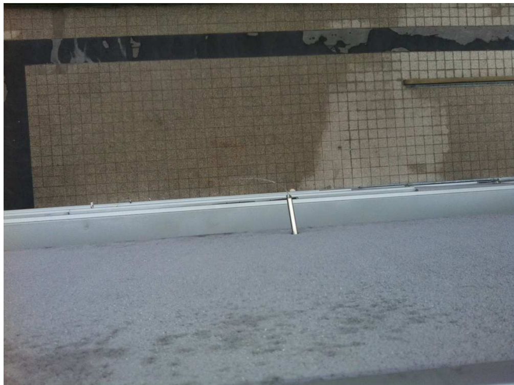
Slika 29: terasa, objekt F3, Zelena Jama – varnostni preliv, voda teče v curku ob dežju, v stanovanju 21, v 6. nadstropju, vhod 58A; BEČIĆ DEDIĆ
