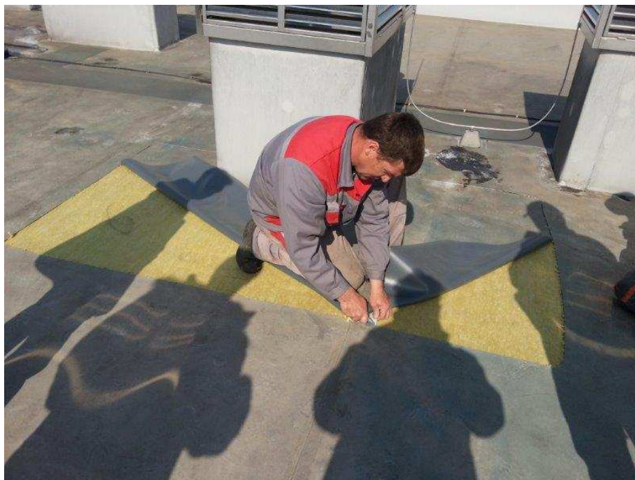
Slika 5: streha objekt F3, Zelena Jama, izrez folije na osi 5
