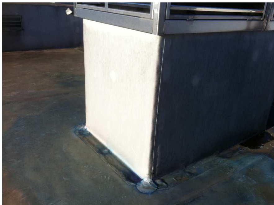
Slika 15: dimnik na strehi objekt F3, Zelena Jama – problem zamakanja, na osi 5, v 5. Nad, Fabjan in Knol
