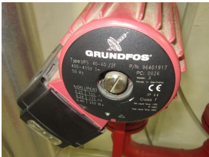
Slika 5.3: Obtočna črpalka dvojne izvedbe GRUNDFOS UPS 40 – 60 /2F s trostopenjsko regulacijo delovanja Vir: lastni vir.
