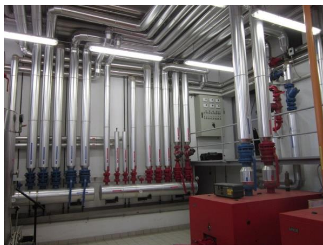
Slika 5.2: Razdelilnik ogrevanja Vir: lastni vir.
