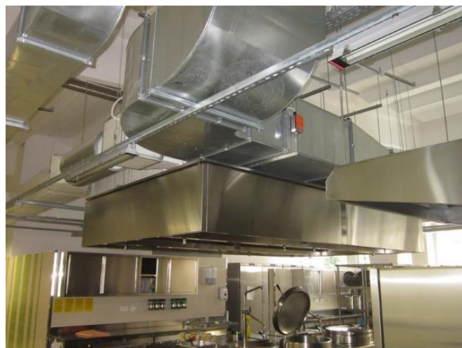
Slika 6.19: Varčevalna napa PROVENT MEDIA RBTB- D 3800 x 2400 Vir: lastni vir.
