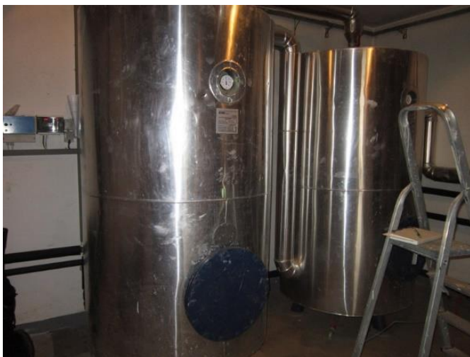
Slika 5.10: Ogrevalnika sanitarne vode prostornine 2 x 1500 litrov, proizvod EMK Vir: lastni vir.
