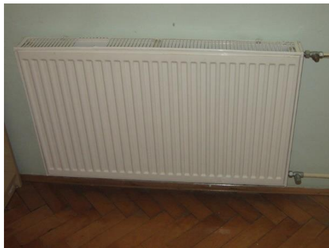
Slika 5.8: Ploščati radiator VOGL&NOOT brez termostatskega ventila
