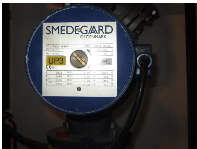
Slika 5.2: Obtočna črpalka ogrevanja SMEDEGARD, tip EV6-95-2C s štiristopenjsko regulacijo hitrosti
