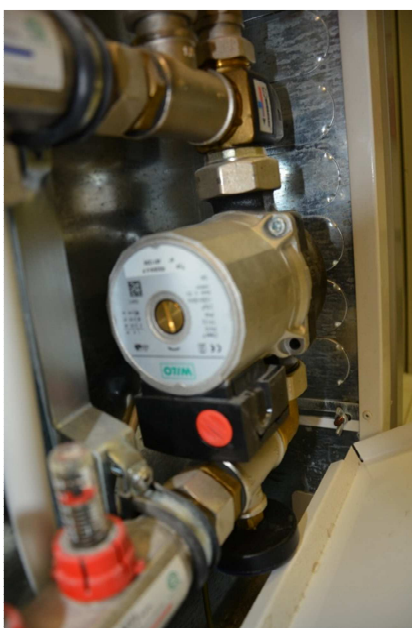
Slika 16: Obtočna črpalka za talno gretje dela dvorane 15
