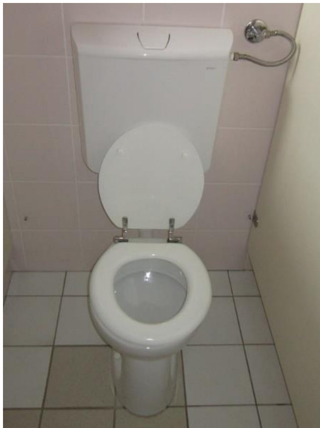
Slika 5.11: WC kotliček brez varčevalne tipke Vir: lastni vir.
