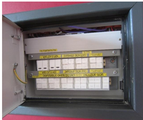
Slika 5.15: posnetek etažnega razdelilca Vir: lastni vir.
