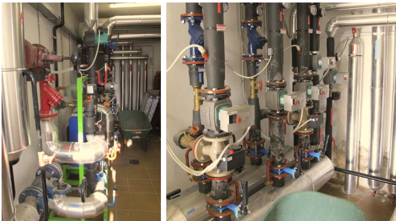
Slika 18: toplotna postaja in razdelilnik (desno)
