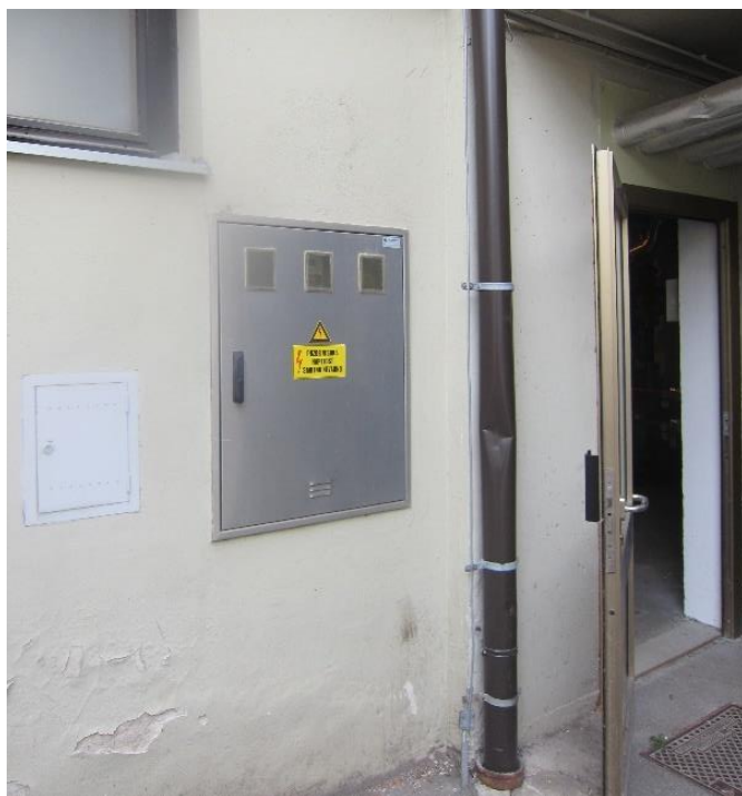
Slika 5.14: Posnetek priključne omare z merilno garnituro Vir: lastni vir.
