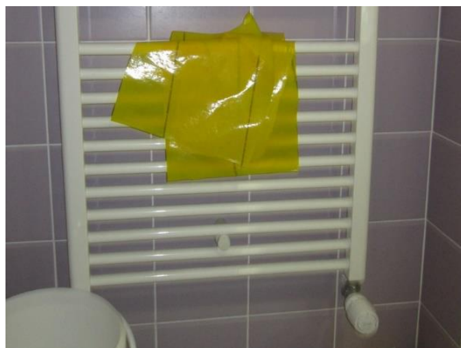
Slika 5.9: Kopalniški radiator s termostatskim ventilom DANFOS Vir: lastni vir.
