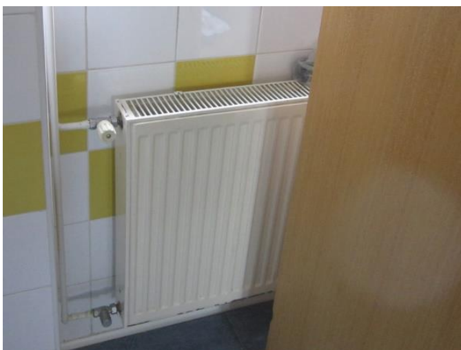
Slika 5.8: Ploščati radiatorji VOGL&NOOT brez termostatskega ventila Vir: lastni vir.
