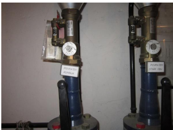
Slika 5.5: Balansirni ventili za hidravlično uravnoteženje razvoda ogrevanja Vir: lastni vir.
