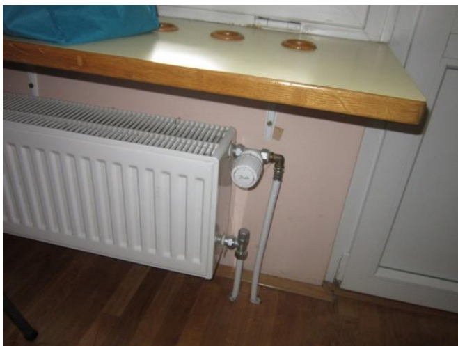
Slika 5.6: Ploščati radiator s termostatskim ventilom DANFOSS Vir: lastni vir.
