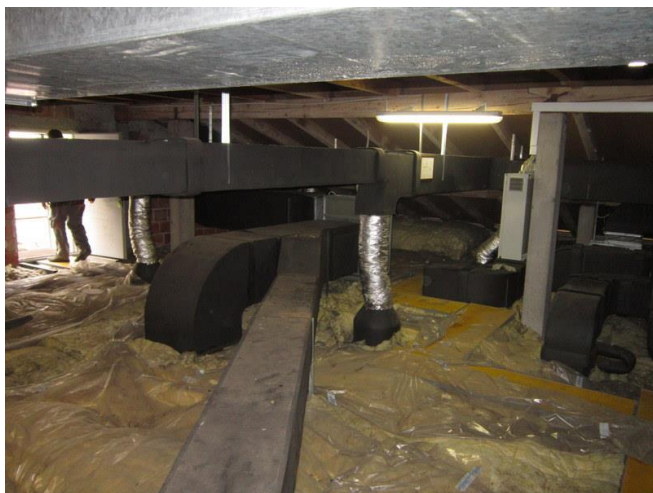
Slika 6.7: Posnetek toplotne izolacije na tleh podstrešja Vir: lastni vir.
