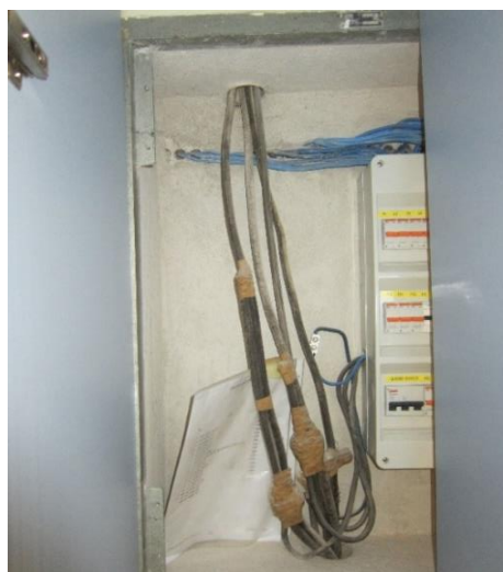
Slika 5.15: posnetek etažnega razdelilca Vir: lastni vir.
