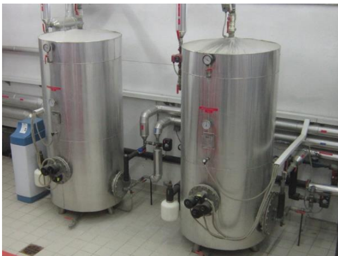
Slika 5.10: Ogrevalnika sanitarne vode podjetja SIMON, d.o.o. Vir: lastni vir.
