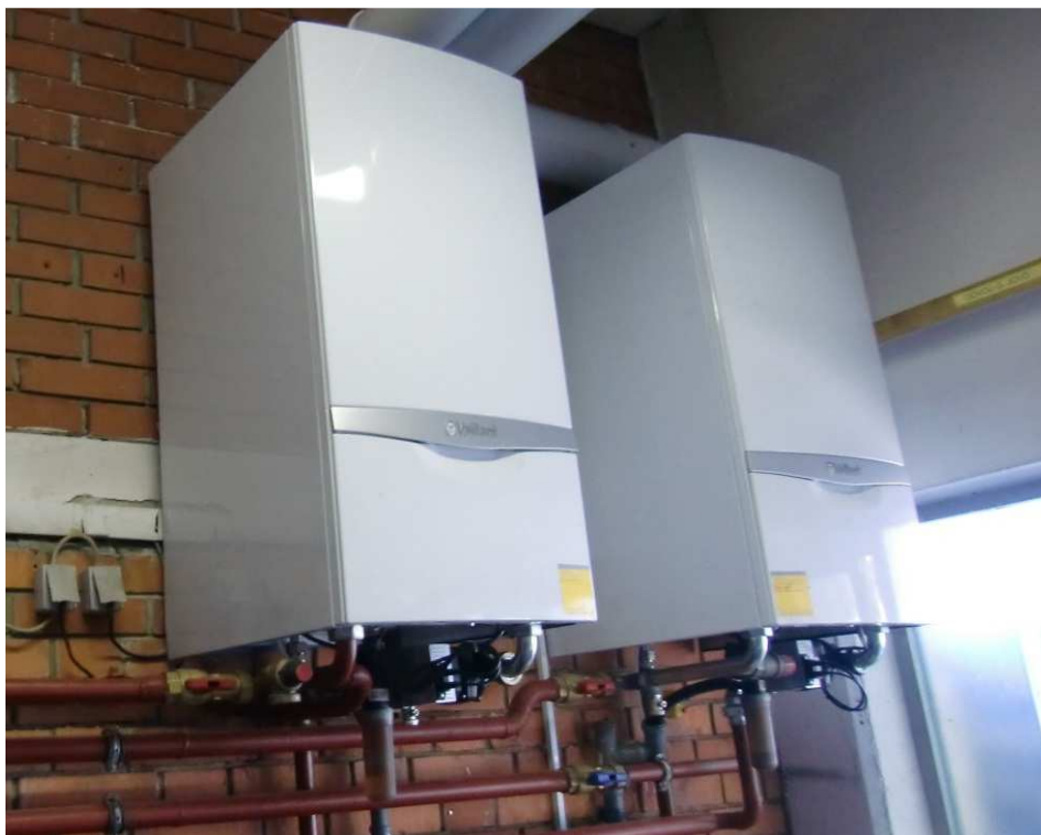
Slika 11: En od kotlov za pripravo bazenske vode in en za ogrevanje in pripravo STV 7
