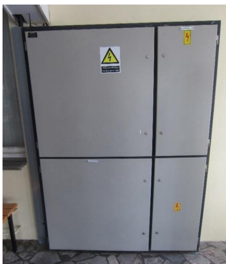
Slika 5.14: Posnetek priključne omare z merilno garnituro Vir: lastni vir.
