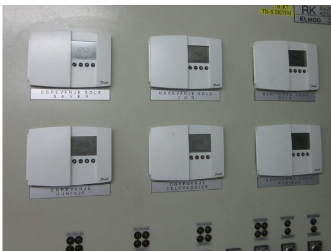
Slika 5.5: Krmilno regulacijske enote ogrevalnega sistema DANFOS Vir: lastni vir.
