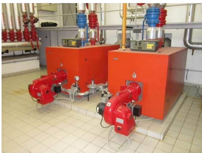
Slika 5.1: Plinski kotla UNICAL tip PREXAL P 500 nazivne toplotne moči 500 kW Vir: lastni vir.
