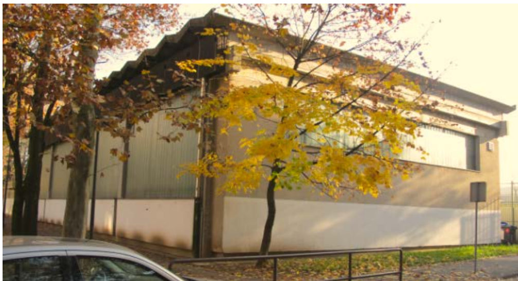
Slika 22: Kopelitna zasteklitev – velika telovadnica
