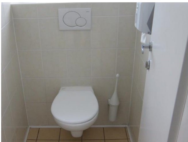
Slika 5.12: Podometni WC kotliček z varčevalno tipko Vir: lastni vir.
