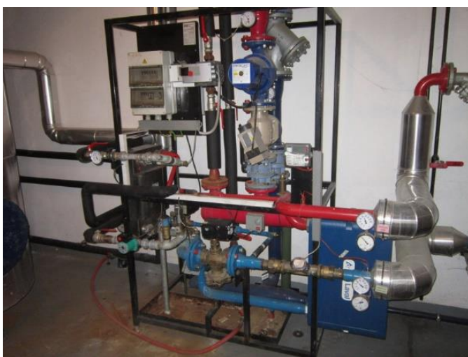
Slika 5.1: KTP nazivne toplotne moči 518 kW
