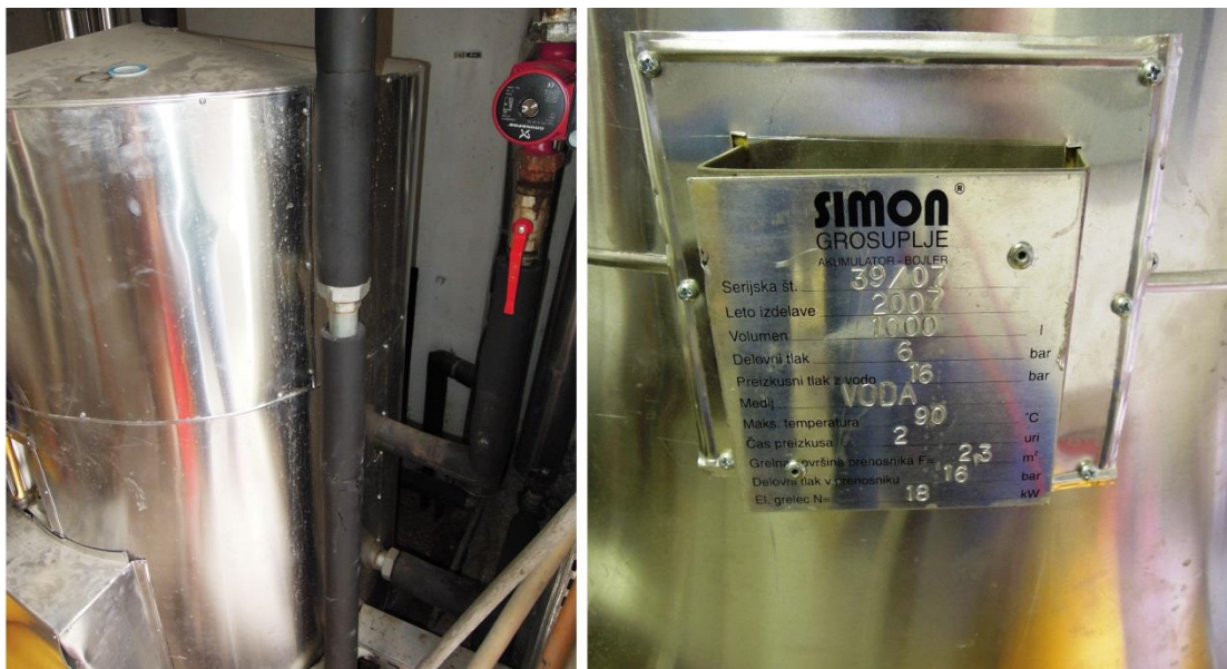
Slika 18: Hranilnik toplote vgrajen v toplotni postaji vrtca
