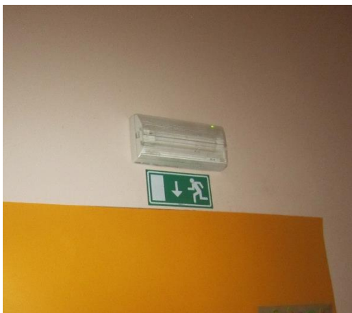
Slika 6.18: Posnetek zasilne razsvetljave
