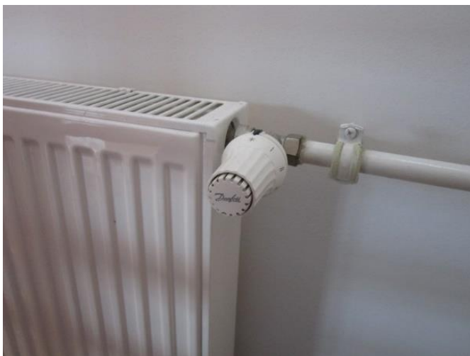
Slika 5.7: Ploščati radiator VOGL&NOOT s termostatskim ventilom
