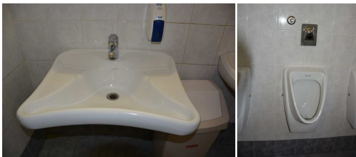
Slika 12: Umivalnik v toaletnih prostorih (levo) in pisoar s senzorjem (desno) 8
