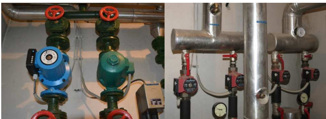
Slika 21: Obtočne črpalke v toplotni podpostaji 21
