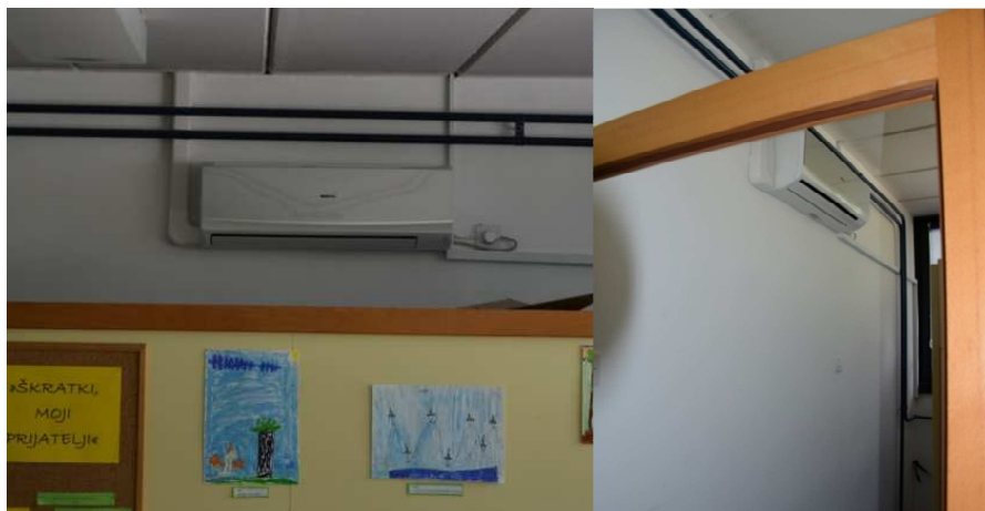
Slika 20: Novejša hladilna split enota proizvajalca BEKO 20
