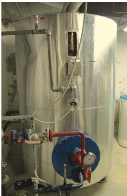
Slika 22: zalogovnik tople sanitarne vode
