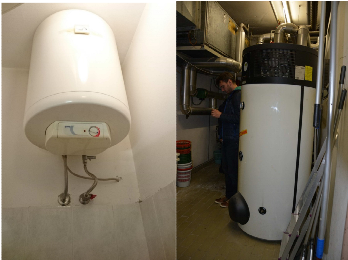
Slika 11: Električni bojler (levo) in toplotna črpalka (desno) 7
