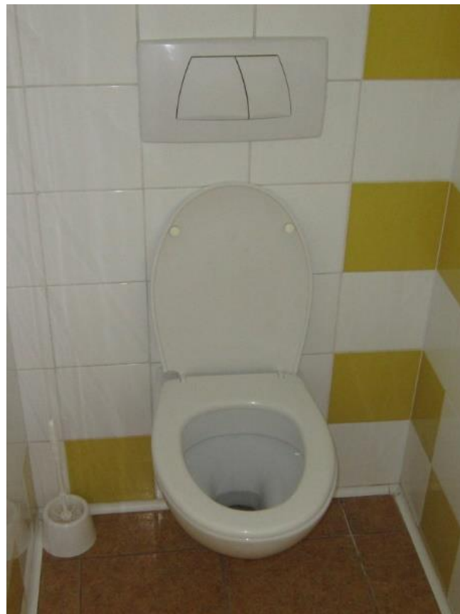
Slika 5.12: Podometni WC kotliček z varčevalno tipko Vir: lastni vir.
