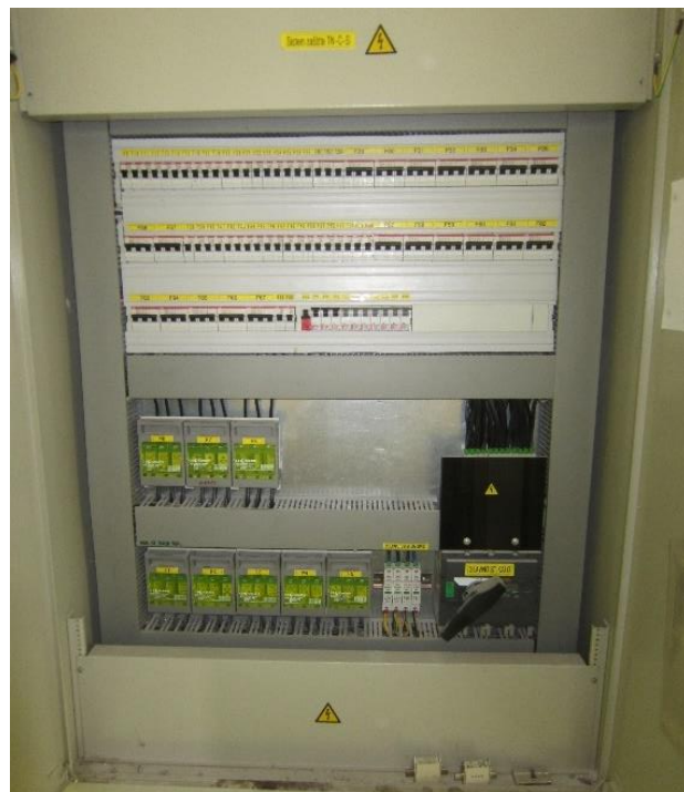
Slika 5.15: Posnetek razdelilca kuhinje Vir: lastni vir.
