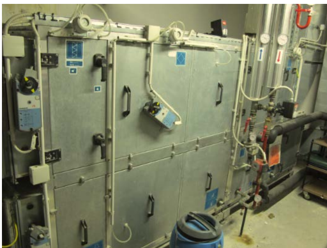
Slika 19: klimat in telovadnica – prezračevalni sistem
