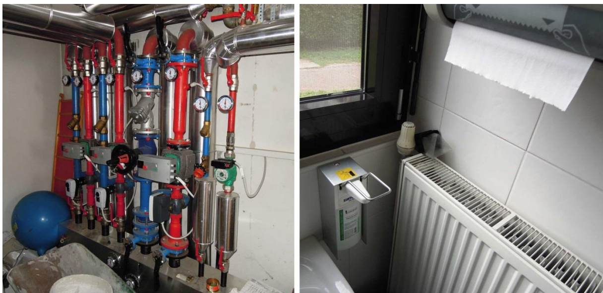
Slika 17: razdelilnik ogrevanja v toplotni postaji (levo); radiatorsko ogrevalo v kuhinji (desno)
