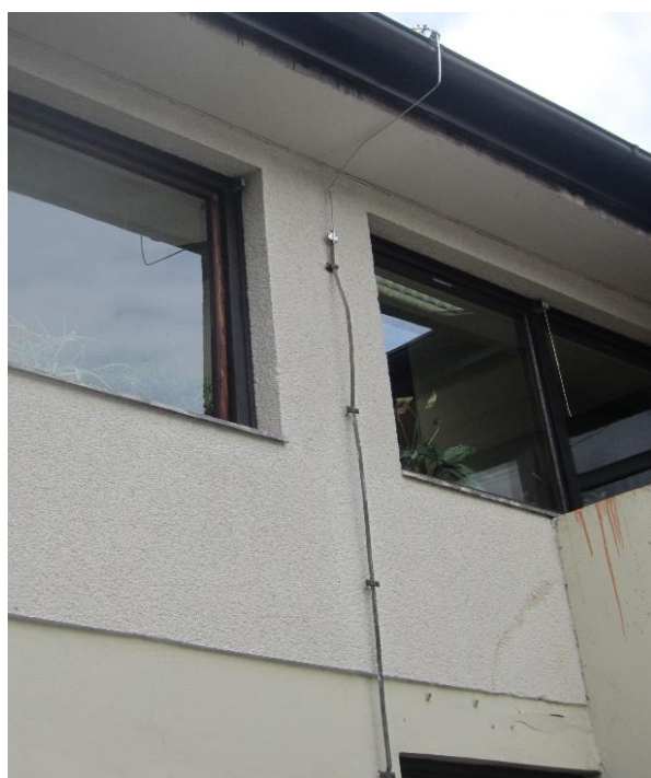
Slika 5.17: Posnetek strelovodne instalacije Vir: lastni vir.
