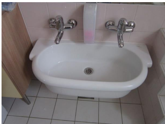
Slika 5.13: Umivalnik s stenskima enoročnima mešalnima baterijama
