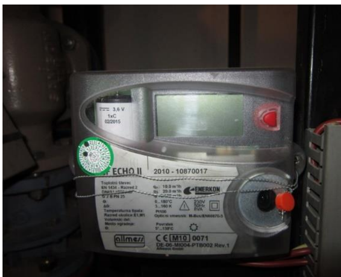
Slika 5.3: Merilnik toplotne energije ALLMESS CF - ECHO II Vir: lastni vir.
