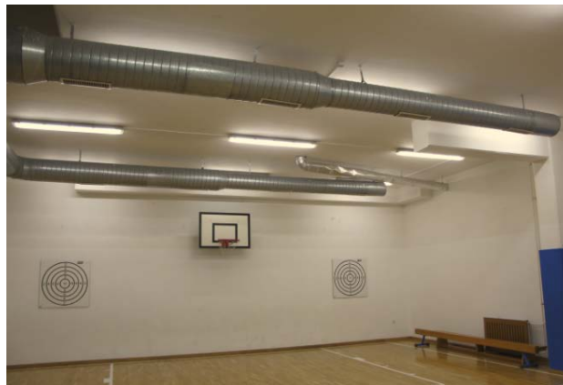
Slika 34: prezračevanje kuhinje (levo); prezračevanje telovadnice (desno)
