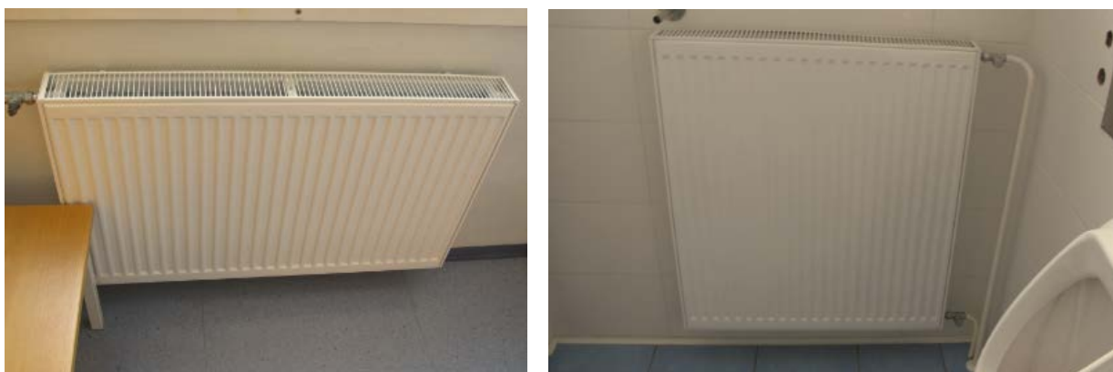
Slika 19: Radiatorsko ogrevanje (levo s v razredu, desno v sanitarijah)
