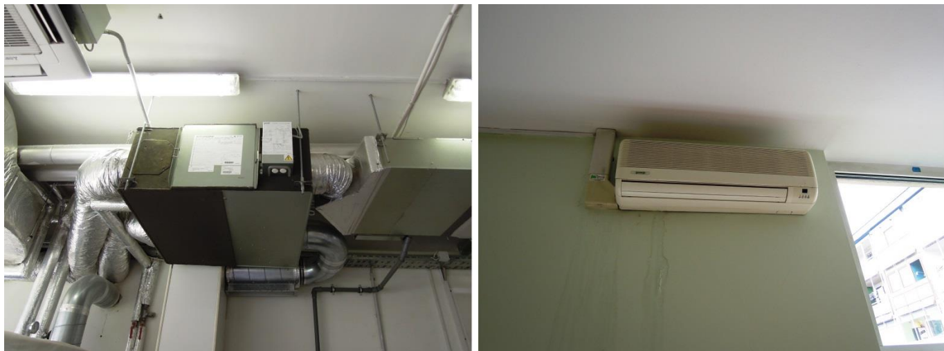
Slika 22: klimat za prezračevanje, vgrajen v pralnici (levo); lokalna klimatska split enota (desno)
