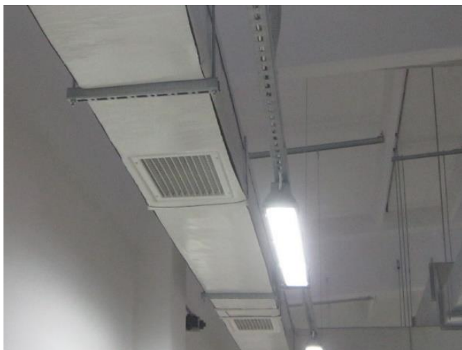
Slika 6.20: Aluminijaste rešetke IMP KLIMA AR-1/2 vgrajene v dovodni Vir: lastni vir.
