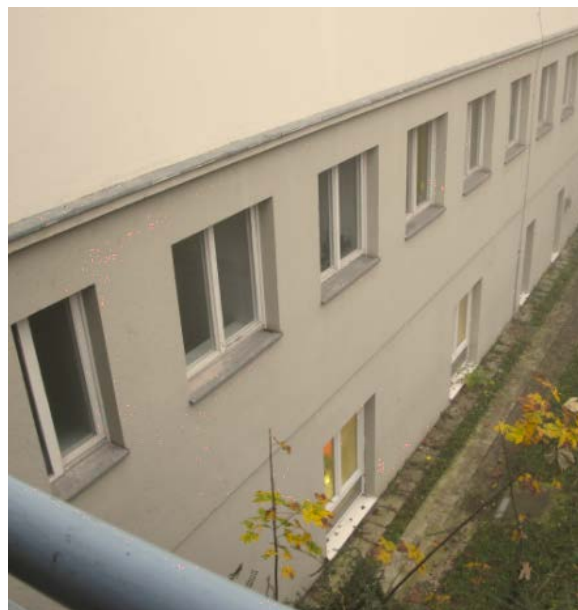
Slika 23: desno so PVC okna – na južni strani objekta, levo so starejša okna (lesena)
