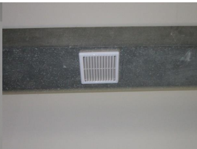
Slika 6.22: Odvodna rešetka v prezračevalnem kanalu – prezračevanje sanitarij igralnic Vir: lastni vir.
