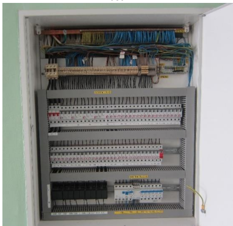
Slika 5.14: Posnetek priključne omare z merilno garnituro Vir: lastni vir.
