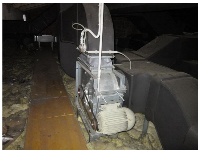
Slika 6.13: Posnetek elektro motorja klimata za kuhinjo Vir: lastni vir.
