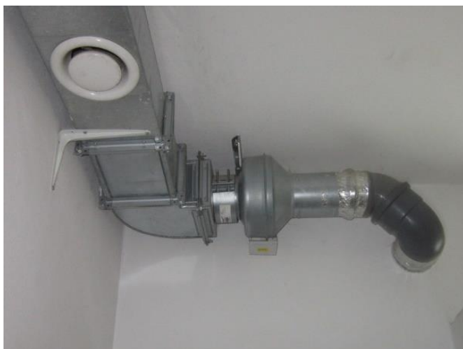
Slika 6.18: Prisilno prezračevanje sanitarij – prezračevalni ventil in kanalski ventilator Vir: lastni vir.
