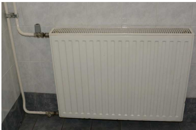
Slika 20: Radiatorji brez termostatskega ventila 18
