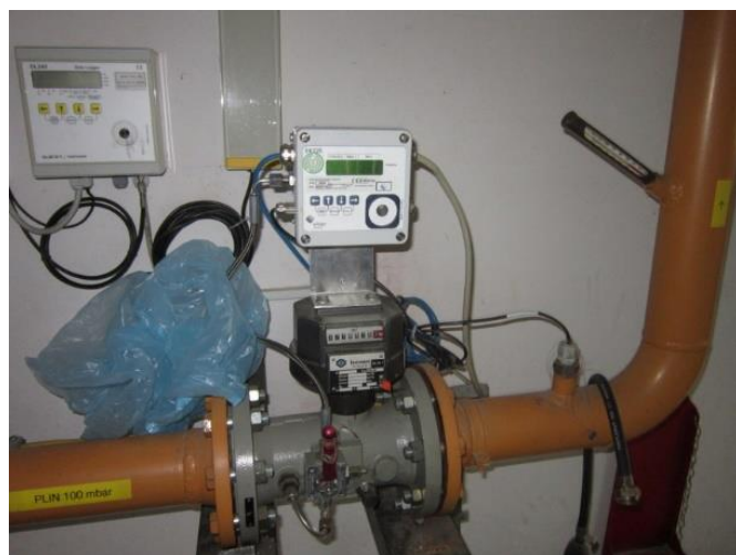
Slika 5.6: Plinomernik s korektorjem tlaka in temperature Vir: lastni vir.
