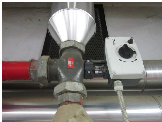
Slika 5.4: Tropotni regulacijski ventil z motornim pogonom Vir: lastni vir.
