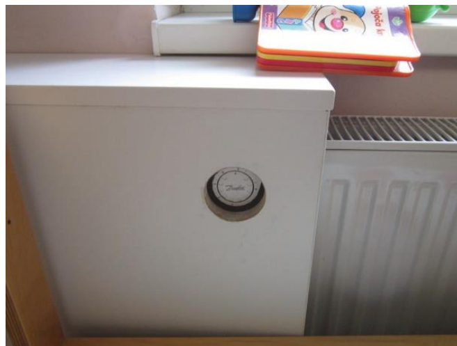
Slika 5.7: Mehanska zaščita termostatskega ventila Vir: lastni vir.
