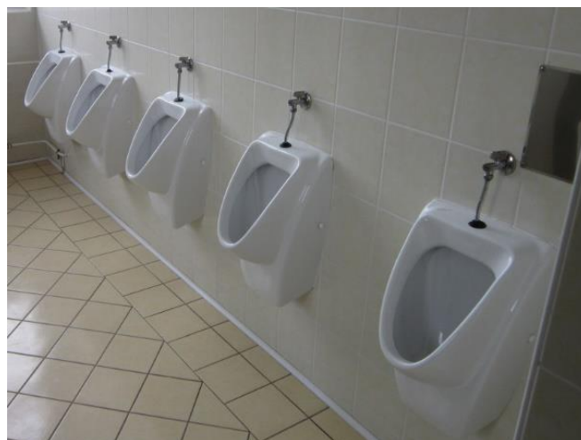
Slika 5.13: Pisoarji opremljeni s senzorjem in ventilom EMV Vir: lastni vir.
