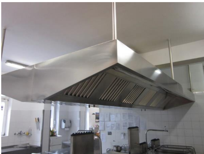
Slika 6.19: Prezračevanje kuhinje – klasična kuhinjska napa Vir: lastni vir.
