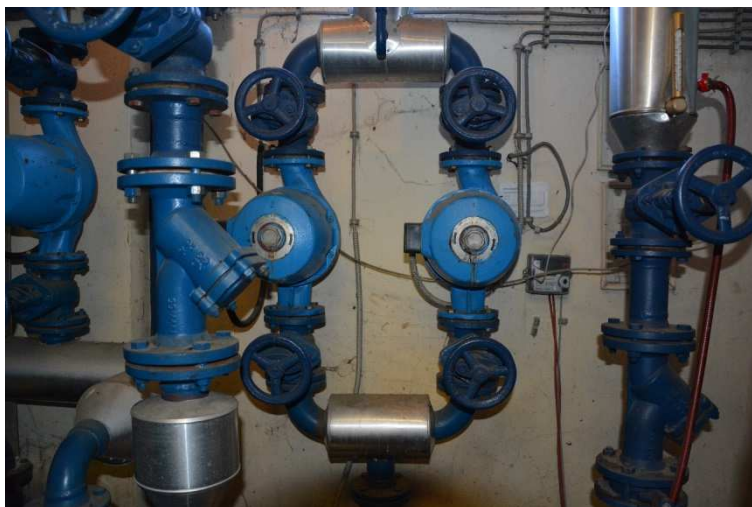
Slika 18: Obtočne črpalke v toplotni podpostaji 16
