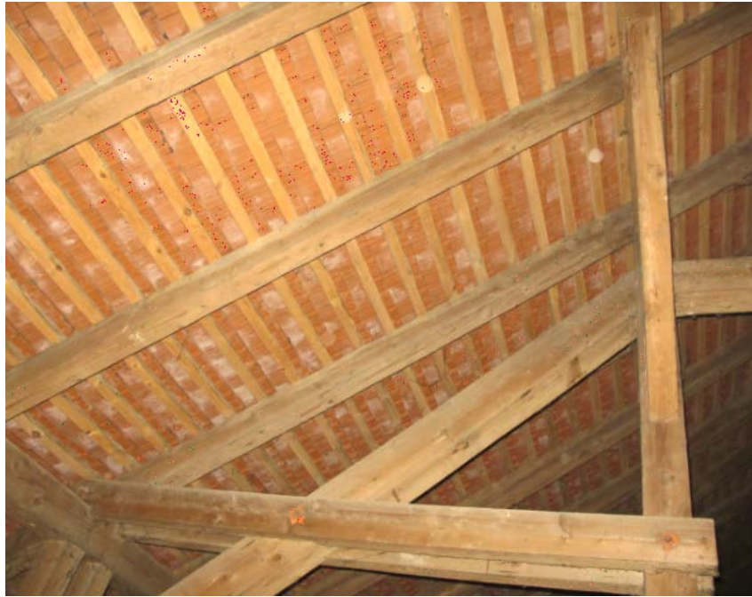
Slika 24: neizolirani del podstrešja
