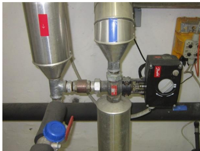
Slika 5.11: Tropotni regulacijski ventili za regulacijo priprave TSV Vir: lastni vir.
