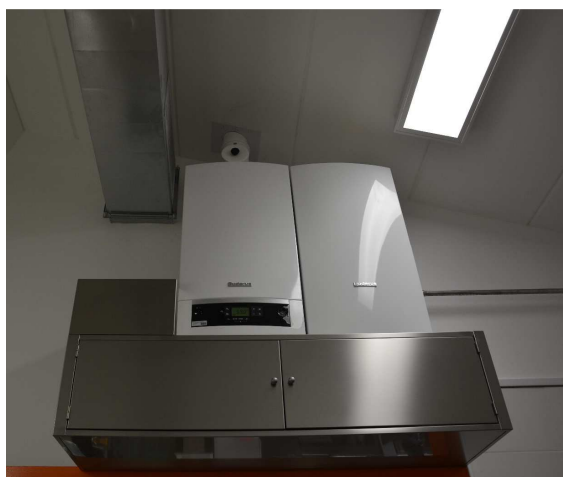
Slika 14: Pretočni plinski kotel 11
