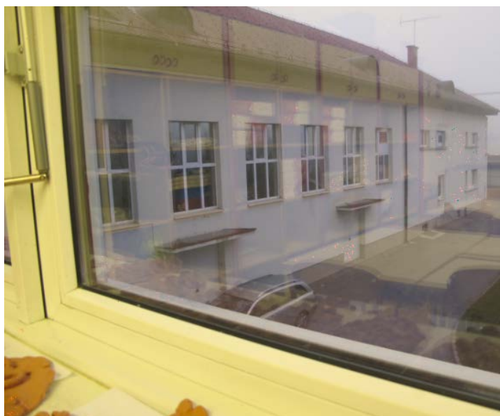
Slika 23: desno so PVC okna – na južni strani objekta, levo so starejša okna (lesena)
