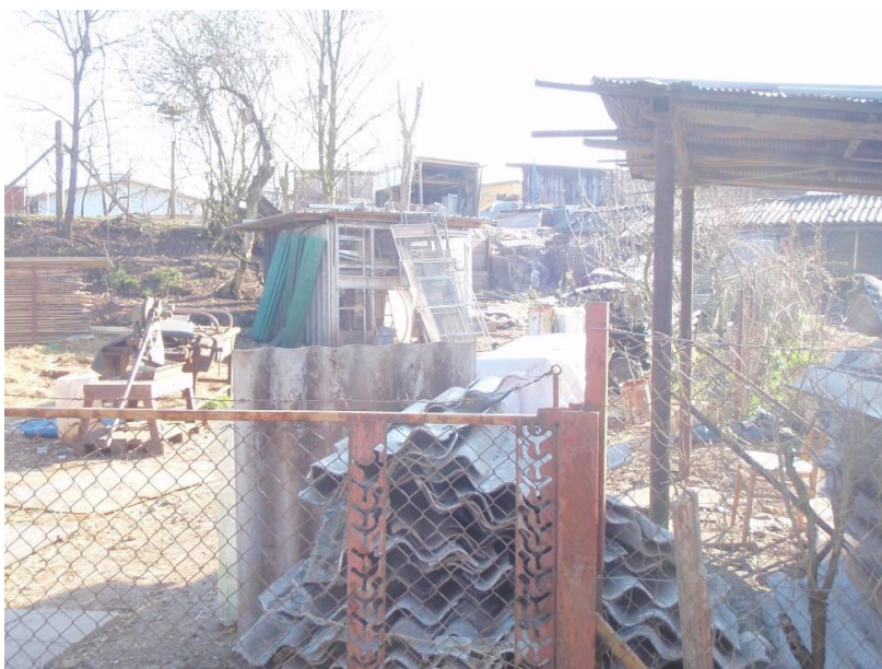
Sliki: Območje načrtovane revitalizacije pred odstranitvijo na črno zgrajenih ali postavljenih objektov
