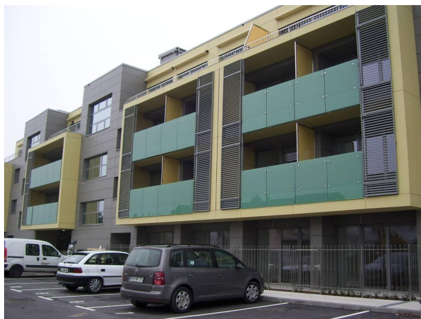
Slika: Novozgrajeni objekti tik pred vselitvijo
