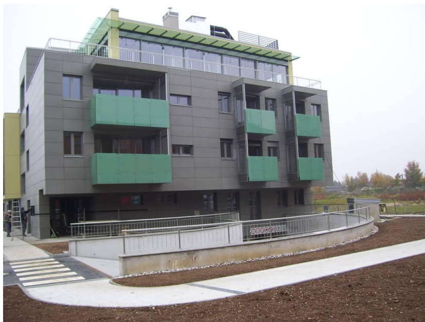
Slika: Novozgrajeni objekti tik pred vselitvijo
