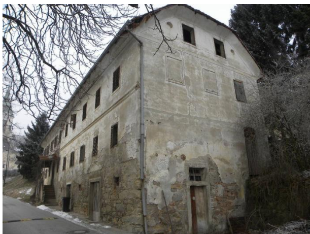
Južna in vzhodna fasada
