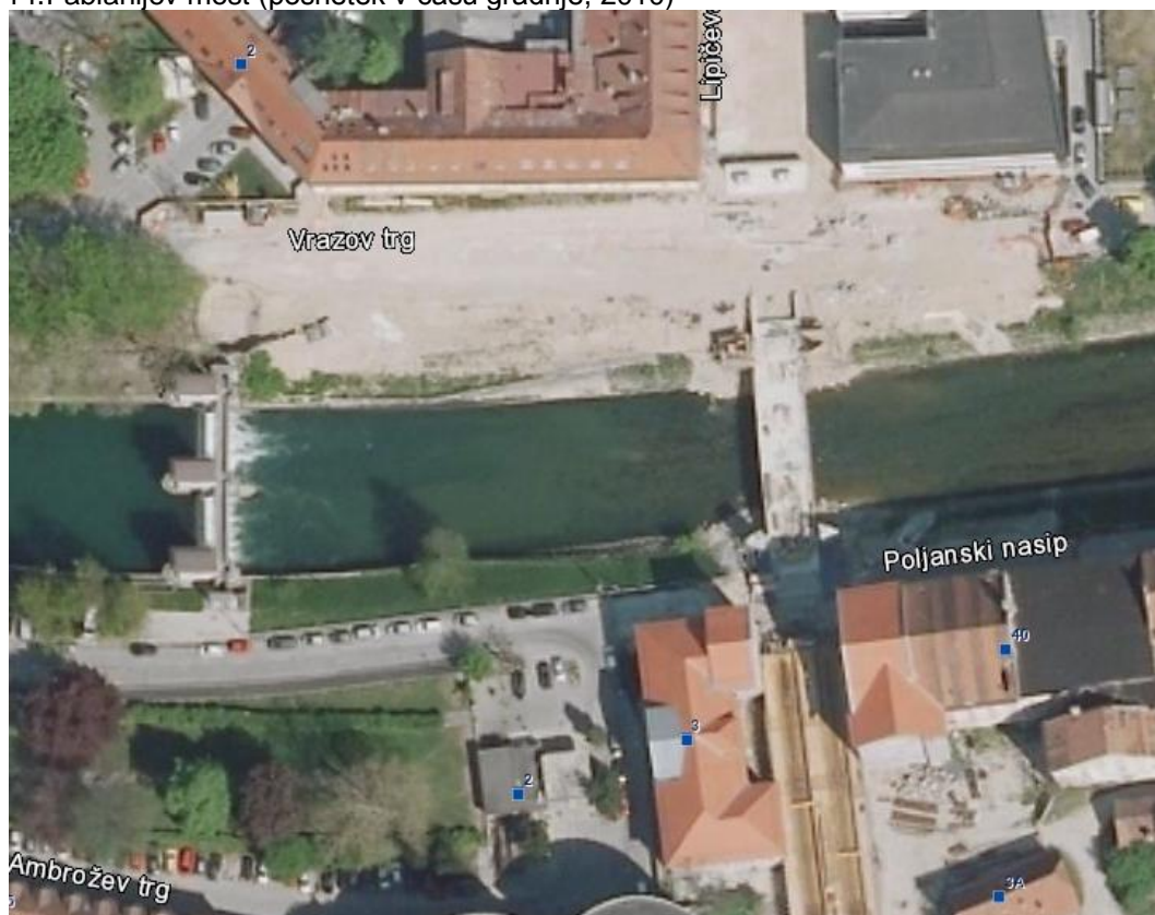
14. Fabianijev most (posnetek v času gradnje, 2010)
