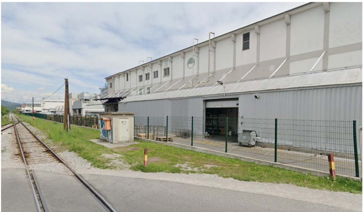
Slika 8: Pogled na območje z Vodovodne ceste; Vir: Google Maps
