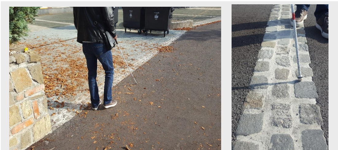
Slika 63 (ustrezno): Primer povezovanja vodilnih robov v območjih višje stopnje dostopnosti s taktilno zaznavnim tlakom. 1: Uporabnik bele palice sledi nestandardni vodilni liniji iz granitnih kock, ki zaključuje tlakovanje na sosednji površini in povezuje dva običajna roba: zid in dvignjen robnik. 2: Pas granitnih kock mora biti širok vsaj 30 cm, da ga je mogoče uporabiti kot vodilno linijo.
