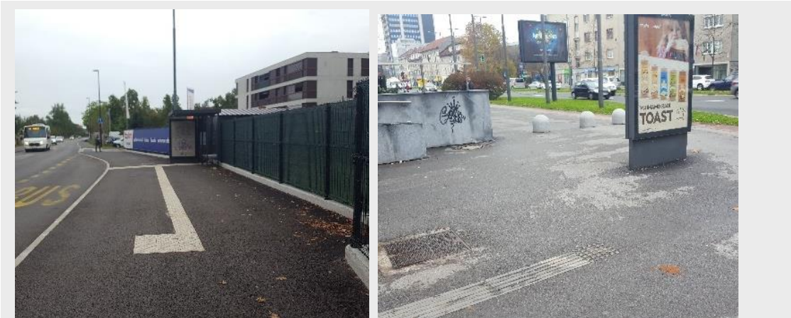
Slika 65 (neustrezno): 1: Taktilne oznake, ki niso povezane z robom in jih zato uporabnik bele palice ne more najti. 2: Poleg tega, da niso povezane z robom, taktilne oznake na sliki tudi niso izdelane v skladu s standardom. Polje, ki označuje začetek, je premajhno, oznake imajo taktilno nezaznavno strukturo in ker so tudi vizualno nekontrastne ne koristijo niti slabovidnim uporabnikom.
