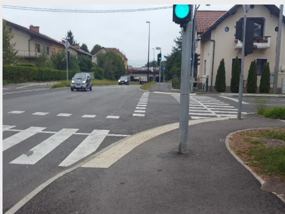
Slika 69: 1 (ustrezno): Primer ureditve v višji stopnji dostopnosti, kjer izvedba vodilnih linij na pločniku ni smiselna. Ker je prostora na pločniku premalo, je ustrezne vodilne linije nemogoče izvesti, saj bi bile prekratke. 2 (neustrezno): Primer oznak, kjer je na majhnem mestu veliko tipnih struktur, ki jih je s palico nemogoče prepoznati.
