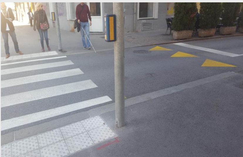
Slika 53 (neustrezno): Primer nezaščitenega roba vozišča. Rob trapezne grbine je pomaknjen daleč izven prehoda za pešce, zato bi bilo treba taktilne oznake podaljšati izven prehoda za pešce do konca grbine.
