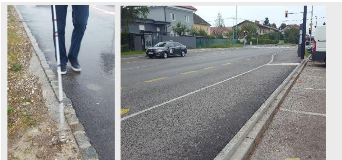
Sliki 19 (neustrezno): Površina ob pločniku leži nižje od pločnika.
