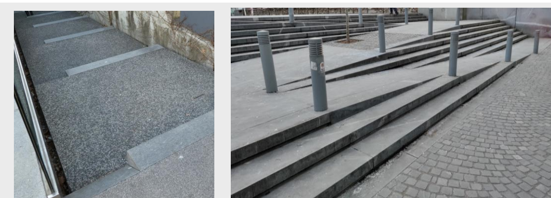
Sliki 36 (neustrezno): 1: Nestandardno stopnišče z dolgimi nastopnimi ploskvami, ki otežuje hojo. V tem primeru uporabo še dodatno otežuje dejstvo, da je del stopnice poševen. Sredi stopnice je rob, ki je zelo nevaren za padec, še toliko bolj zato, ker robovi niso kontrastni in jih je zelo težko zaznati. 2: Stopnišče z integrirano klančino je vključujoče le na prvi pogled, sicer pa je za večino uporabnikov s funkcionalnimi oviranostmi neuporabno, saj so klančine neustrezno opremljene, robovi klančin so nezaščiteni, za slabovidne pa je zelo otežena zaznava robov stopnic.
