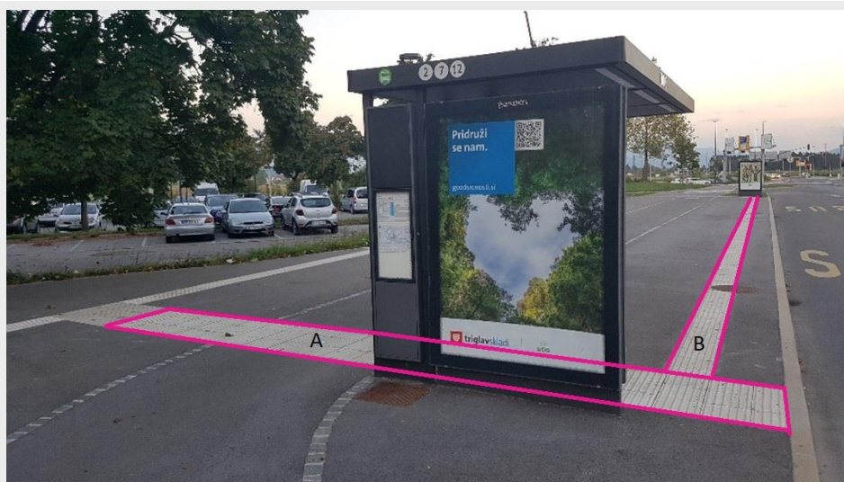
Slika 57 (ustrezno): Primer postajališča, označenega s kombinacijo standardnih oznak – del ob vstopnem mestu. Oznaka vstopnega mesta (A) je postavljena tako, da poteka neposredno ob informacijskem stebru. Taktilna vodilna linija (B) poteka vzdolž celega perona 60 cm od robnika ob cesti in se (brez čepaste oznake!) pripenja na oznako vstopnega mesta. Ta linija je pomembna zato, da pri izstopu iz avtobusa uporabnik bele palice lahko najde pot do roba pločnika.
