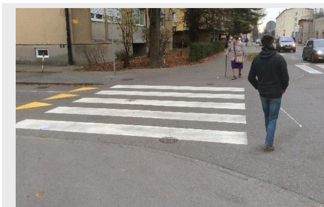
Slika 12 (neustrezno): Prehod za pešce na trapezni ploščadi, ki je zelo priporočljiv za izboljšanje prehodnosti za pešce, vendar je pomanjkljivo opremljen z vidika slepih in slabovidnih. Ker manjkajo taktilne oznake, ki označujejo rob peščeve površine, ljudje z okvarami vida lahko nevede zaidejo na cesto.
