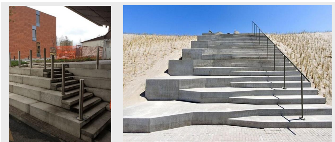
Sliki 34: 1 (neustrezno): Stopnišče, kjer robovi in smer gibanja niso jasno izraženi, kar otežuje uporabo predvsem ljudem s slabšo vidno zaznavo. Za mnoge uporabnike je takšno stopnišče prenevarno, da bi ga lahko uporabljali. 2 (ustrezno): Stopnišče z izraženo glavno smerjo hoje, ki jo poudarja oprijemalo. Pot po kompleksnih stopniščih je tako lažja (opomba: manjkajo kontrastni robovi stopnic) (vir: https://pin.it/dpptvtU ).
