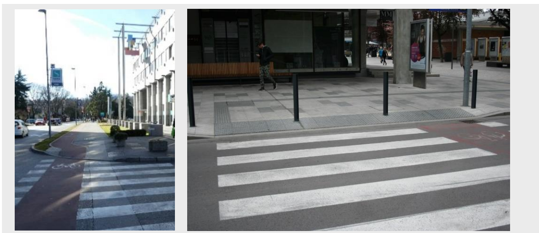
Sliki 27 : Znižani robniki v območju prehodov za pešce. 1 (neustrezno): Primer znižanega robnika, ki je pešcem manj prijazen. Gibalno ovirani pešci se usmerijo na površino za kolesarje (predvsem, kadar je na prehodu večje število ljudi). 2 (ustrezno): Z ureditvijo znižanih robnikov v celotni širini zebre je omogočen varen prehod večji skupini ljudi, saj sredi zebre ni poševnih robnikov, ki so težavni za spotikanje. Na ta način se tudi lažje izvede blag prehod z ene na drugo višino, ki je pri klančinah sicer pogosto zelo strm in ga je z vozičkom težko prevoziti.
