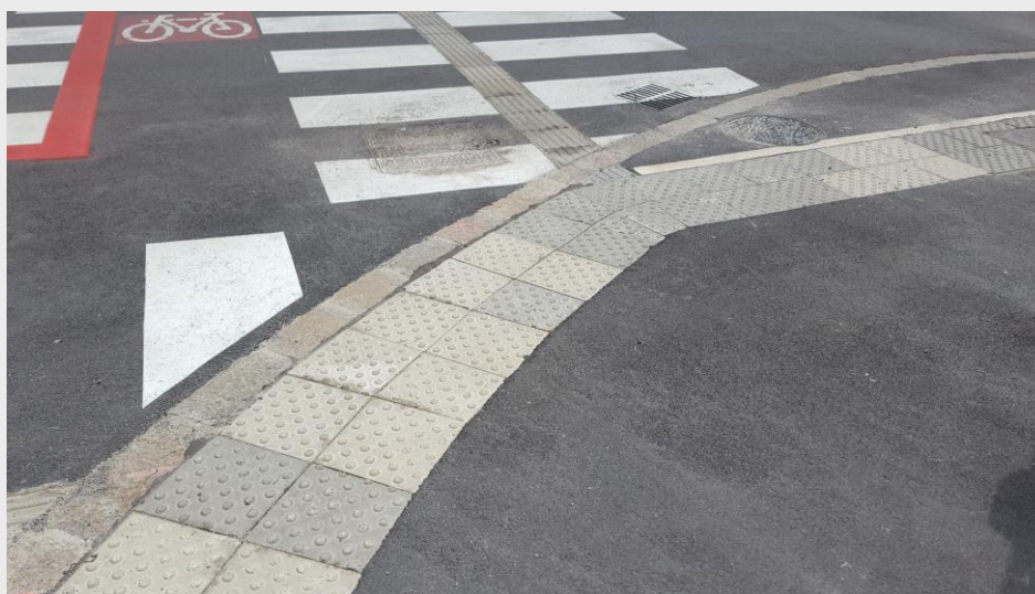
Slika 50 (neustrezno): Ob dopolnjevanju ureditve so bile uporabljene taktilne plošče različnih barv.
