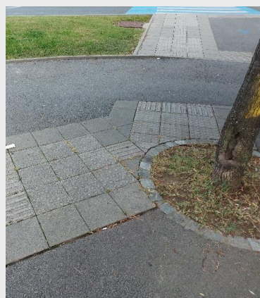
Slika 69: 1 (ustrezno): Primer ureditve v višji stopnji dostopnosti, kjer izvedba vodilnih linij na pločniku ni smiselna. Ker je prostora na pločniku premalo, je ustrezne vodilne linije nemogoče izvesti, saj bi bile prekratke. 2 (neustrezno): Primer oznak, kjer je na majhnem mestu veliko tipnih struktur, ki jih je s palico nemogoče prepoznati.
