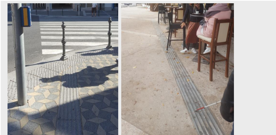
Slika 72 (neustrezno): 1 Naknadno umeščen količek ovira uporabo taktilne vodilne linije, saj je nameščen neposredno na vodilni poti. Umaknjen bi moral biti vsaj 60 cm od smeri, ki jo določa vodilna linija. 2 V načrtu ni bil upoštevan gostinski vrt, ki po izvedbi posega na taktilno oznako.
