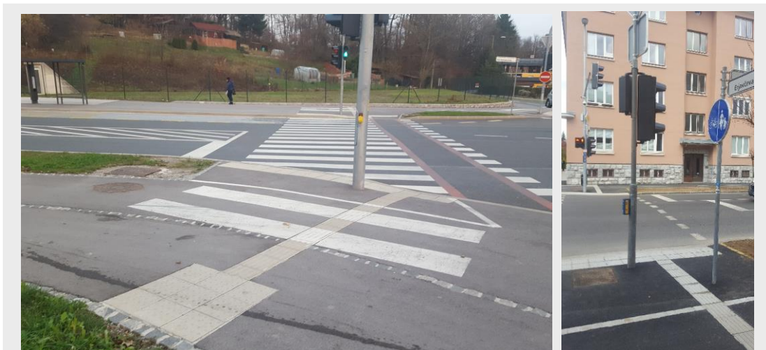
Slika 70: Smer vodilnih linij. 1 (neustrezno): Primer oznake, ki usmerja pešca v napačno smer- v sredino križišča. 2 (ustrezno): Primer oznak, ki so usklajene na obeh straneh ceste.
