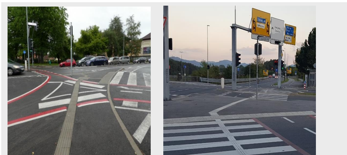
Sliki 11: Primera talnih označb na cestnem otoku. 1 (neustrezno): Talnih označb je preveč in zato lahko zelo zmedejo uporabnika. 2 (ustrezno): Talne označbe podajajo zgolj ključne informacije tako v taktilni kot v vizualni obliki: poudarjena sta rob ceste (nevarnost) in glavna smer prehoda čez cesto za pešce.
