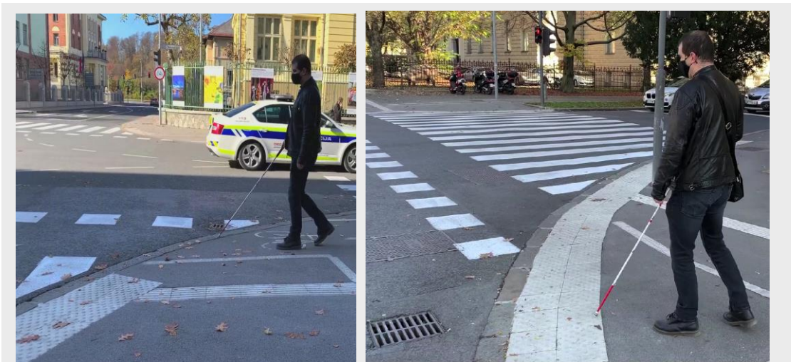
Slika 54: Taktilne oznake v križišču s poglobljenimi robniki v primeru kolesarskega pasu na pločniku. 1 (neustrezno): Na mestu kolesarskega prehoda je taktilna oznaka prekinjena, uporabnik bele palice pa je zaradi nepredvidenega dogodka izgubil orientacijo in v iskanju oprijemljivega roba zašel v križišče. 2 (ustrezno): Taktilne oznake označujejo rob ceste tudi na prehodu kolesarske steze. Uporabnik bele palice, ki je zaradi nepredvidenega dogodka izgubil orientacijo, otipa rob, po kateremu lahko sledi do varne orientacijske točke (npr. semaforja).
