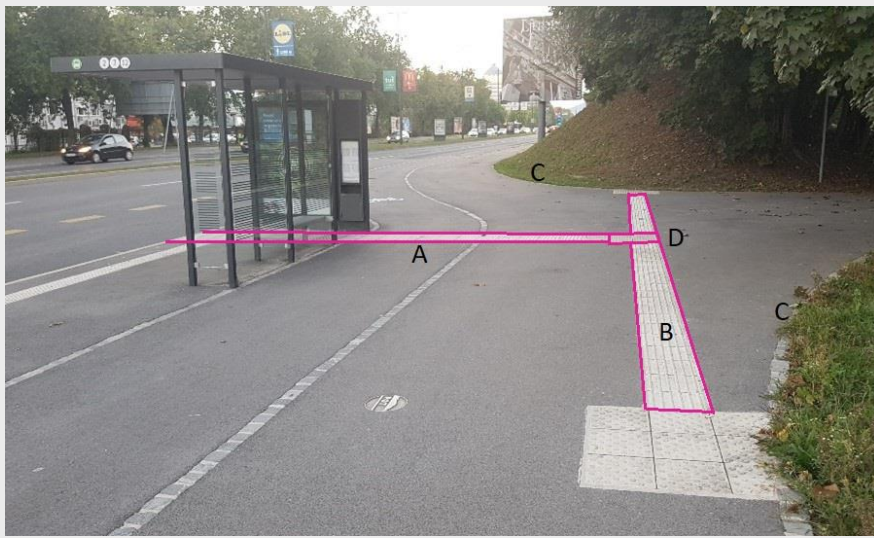
Slika 59 (ustrezno): Primer pripenjanja taktilne oznake vstopnega mesta na vodilno linijo. Oznake vstopnega mesta (A) ni možno pripeti neposredno na rob, zato je izvedena dodatna vodilna linija (B), ki povezuje dva vodilna robova (C). Oznaka vstopnega mesta (A) se na vodilno linijo pripenja s čepastim poljem (D).
