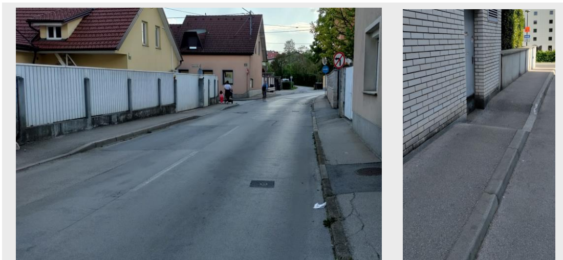
Sliki 26 (neustrezno): Ovire za prehod z vozičkom na pločnikih 1 : Prestrm prečni naklon pločnika 2 : uvozi, ki prekinjajo pločnik s strmimi klančinami.
