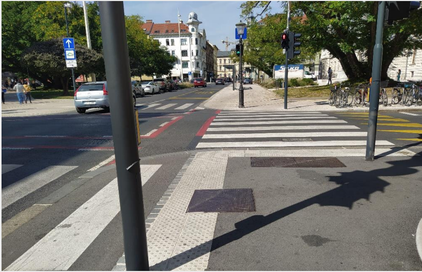
Slika 52 (ustrezno): Označitev roba varne površine s čepastimi oznakami v nivojskem križišču v primeru, ko teče kolesarski pas ob cesti. Zvočni semafor je postavljen neposredno ob čepasti oznaki.
