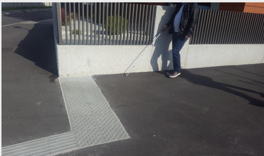
Slika 66 (ustrezno): Primer vodilne linije, ki je ustrezno navezana na rob s podolgovatim obvestilnim poljem.
