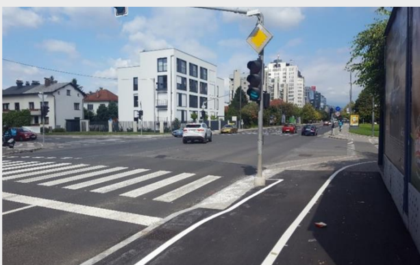
Slika 8 (neustrezno): Primer premajhne površine za čakanje pešcev na prehodu za pešce. Pešci, ki čakajo prehodu za pešce, ovirajo pot kolesarjev. Pešci zato pogosto čakajo pred kolesarskim pasom, kar pomeni, da se zanje pot čez cesto občutno podaljša. Ob cesti je treba omogočiti dovolj široko površino za čakanje uporabnika na invalidskem vozičku, ne da bi s tem posegal na kolesarsko stezo.
