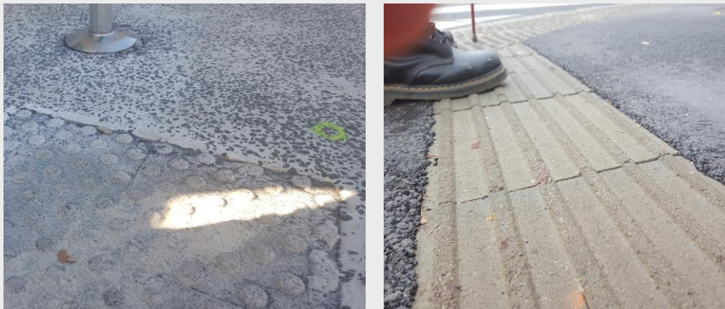
Sliki 48 (neustrezno): Oznake so ugreznjene glede na okoliški tlak in zato s palico in stopali zelo težko zaznavne.
