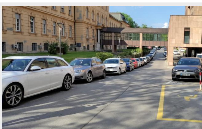
Slika 15 (neustrezno): Pogost primer pred javnimi ustanovami. Poti za pešce ni, zato mora pešec do vhoda v stavbo po cesti oziroma čez parkirišče.
