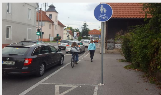
Slika 5 (ustrezno): Primer ureditve, kjer je kolesarski pas pred križiščem prekinjen, kolesar pa je na to dodatno opozorjen s talno označbo. Kolesar mora prilagoditi svojo hitrost pešču.
