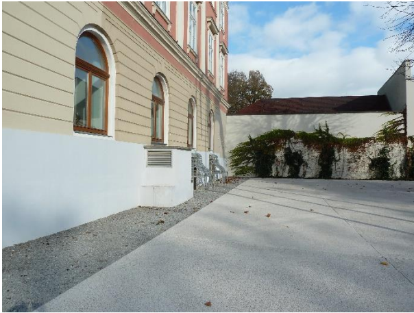
Slika 6: Pogled na detajle vzhodne fasade objekta Kazina
