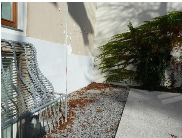
Slika 7: Pogled na detajle vzhodne fasade objekta Kazina
