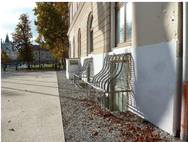
Slika 8: Pogled na detajle vzhodne fasade objekta Kazina
