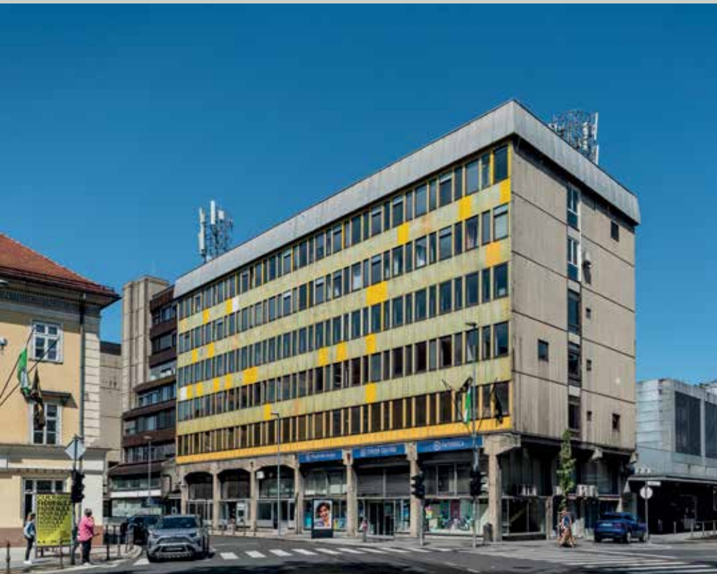
3 Založba in tiskarna Ljudska pravica, Kopitarjeva ulica 2, načrt 1957, gradnja 1958–1961 (foto: B. Zupančič). Ljudska Pravica Building, Kopitarjeva ulica 2 , plan: 1957, construction: 1958–1961 (photo: B. Zupančič).
