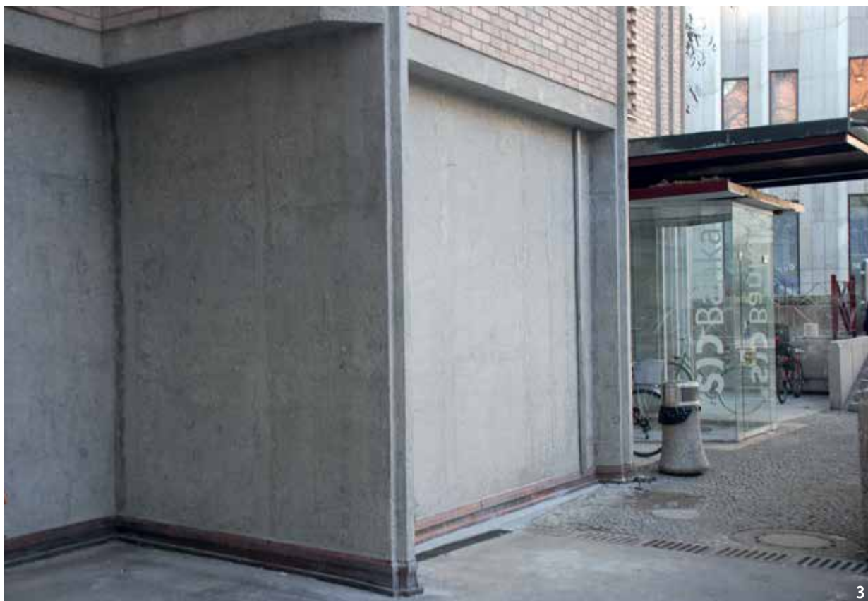
3 Strokovno obnovljena površina vidnega betona v pritličju fasade nekdanje poslovne stavbe podružnice Ljubljanske banke na Ulici Josipine Turnograjske (foto: T. Adamič). Professionally renovated bare concrete surface on the ground-floor facade of the former Ljubljanska Banka office building on Josipina Turnograjska Street (photo: T. Adamič).
