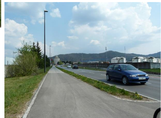
5. Pogled z Zaloške ceste na vzhod, proti coni Petrol.
